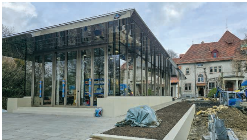
Der neue Pavillon ist fertiggestellt
