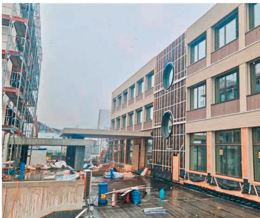
Der Innenausbau der neuen Schulgebäude läuft auf Hochtouren BILD: ZVG
