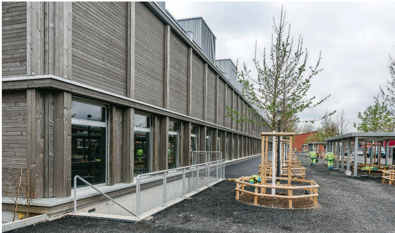
Nach den Frühlingsferien wurde der Unterricht im Neubau Dohlenzelg aufgenommen
