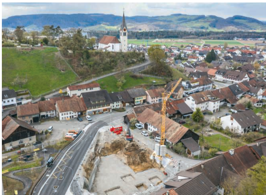
Rettungsgrabung 2021 an der Sonnenbergstrasse 2 bis 6 in Würenlingen BILD: ZVG
