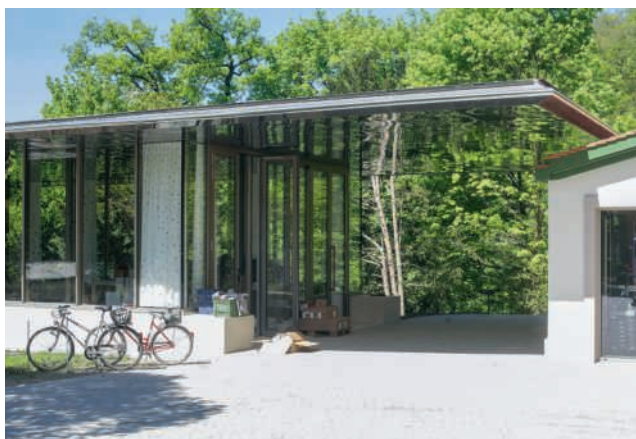
Pavillon «en plein air»
