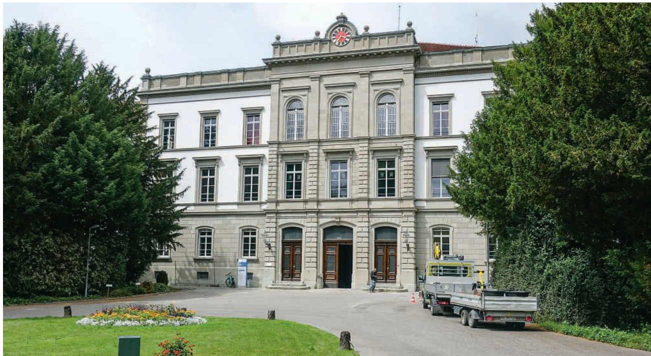
Mit der Inbetriebnahme des Hauptgebäudes haben die PDAG die Gesamtanierung ihres Klinikareals abgeschlossen BILD: LEH
