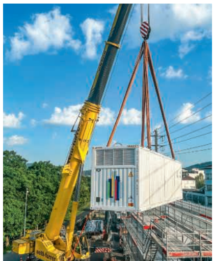
Projekt Grossbatteriespeicher Bess I an der Fohrhölzlistrasse 11: Der erste Batteriecontainer wurde letzte Woche platziert BILD: ZVG
