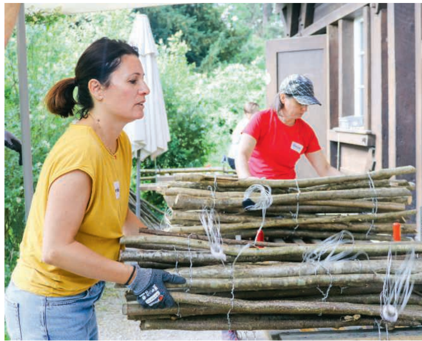
Voller Einsatz beim Bau von neuen Schutzzäunen für den Römergarten BILD: SSP
