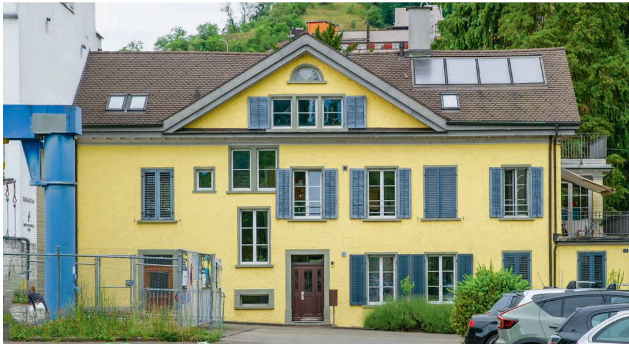
Der Einwohnerrat hat beschlossen, das Dachgeschoss der Liegenschaft an der Kanalstrasse 14 für 980 000 Franken auszubauen und zehn zusätzliche Plätze für Flüchtlinge zu schaffen
